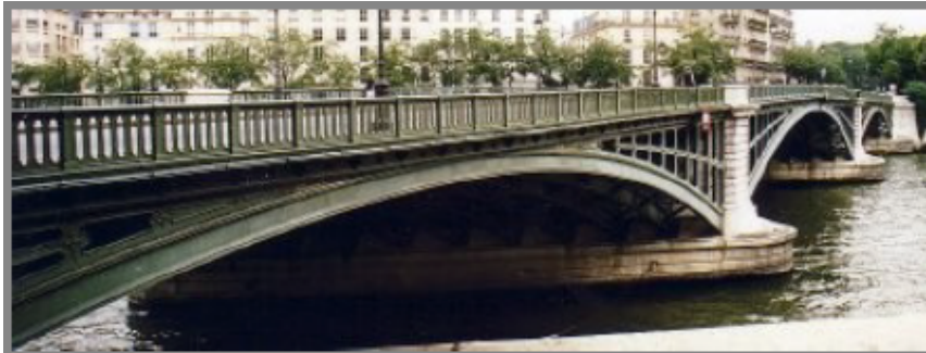
Pont Sully – Paris – 1876 Un des (rares) ponts en fonte encore en service
