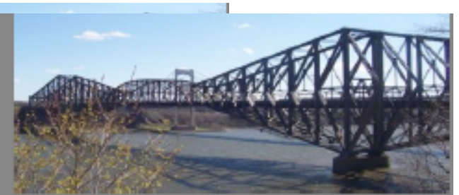
Un pont à poutre cantilever en treillis
