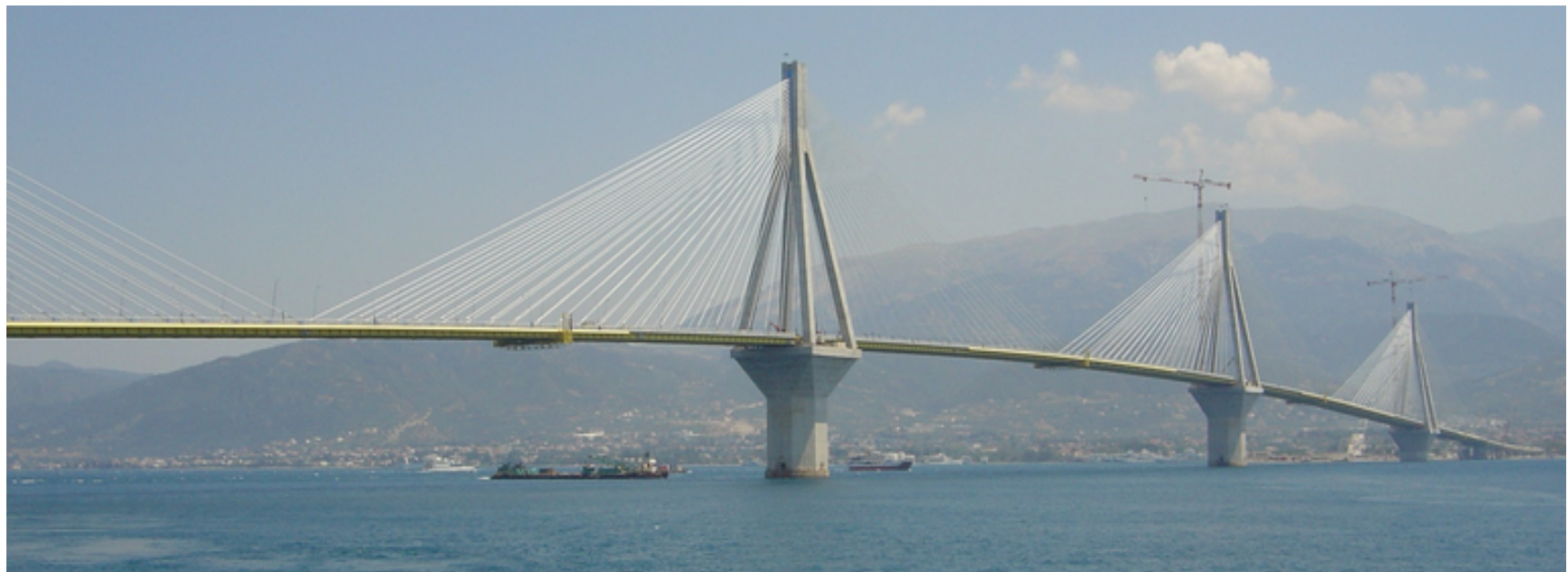
le pont Rion Antirion qui franchit l'isthme de Corinthe, Grèce
