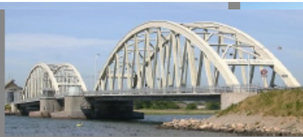
Un pont en arc à tablier suspendu
